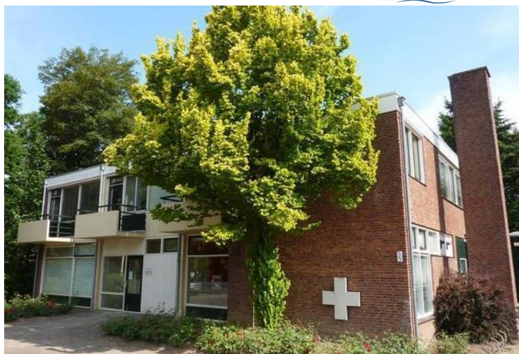
Figuur 6.5: aanzicht vanaf de Prinses Margrietstraat
