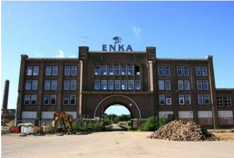
Figuur 4.6: Gevel van voormalige kunststoffenfabriek Enka
