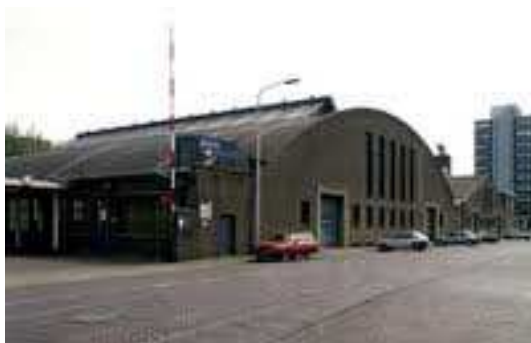
Figuur 4.12: RAC hallen in Den Haag
