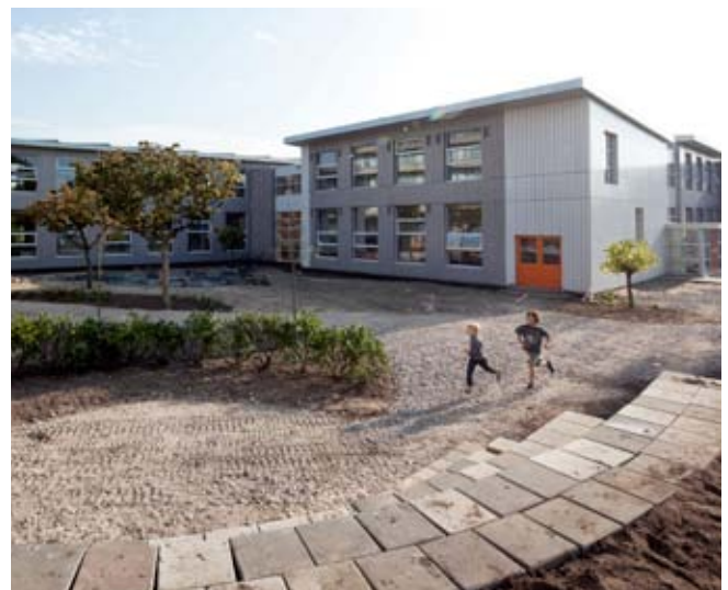
OBS De Wilgenstam in Rotterdam is in de zomervakantie van 2011 in acht weken tijd verbeterd van energielabel G naar A. Dit is een van de NESK voorbeeldprojecten (Naar Energieneutrale Scholen en Kantoren).
