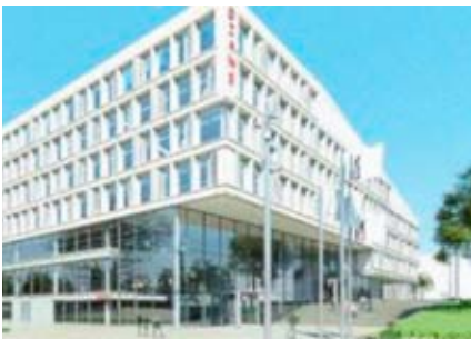
Gemeente Groningen heeft voor het nieuwe gebouw voor de Dienst Sociale Zaken en Werk gekozen voor integrale aanbesteding via engineer, build en maintain.
