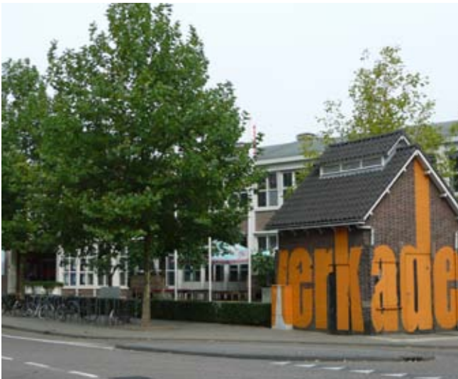
De gemeente 's-Hertogenbosch heeft de Verkadefabriek verbouwd tot een bruisend cultureel centrum. Het gebouw ging van label G naar A + .
