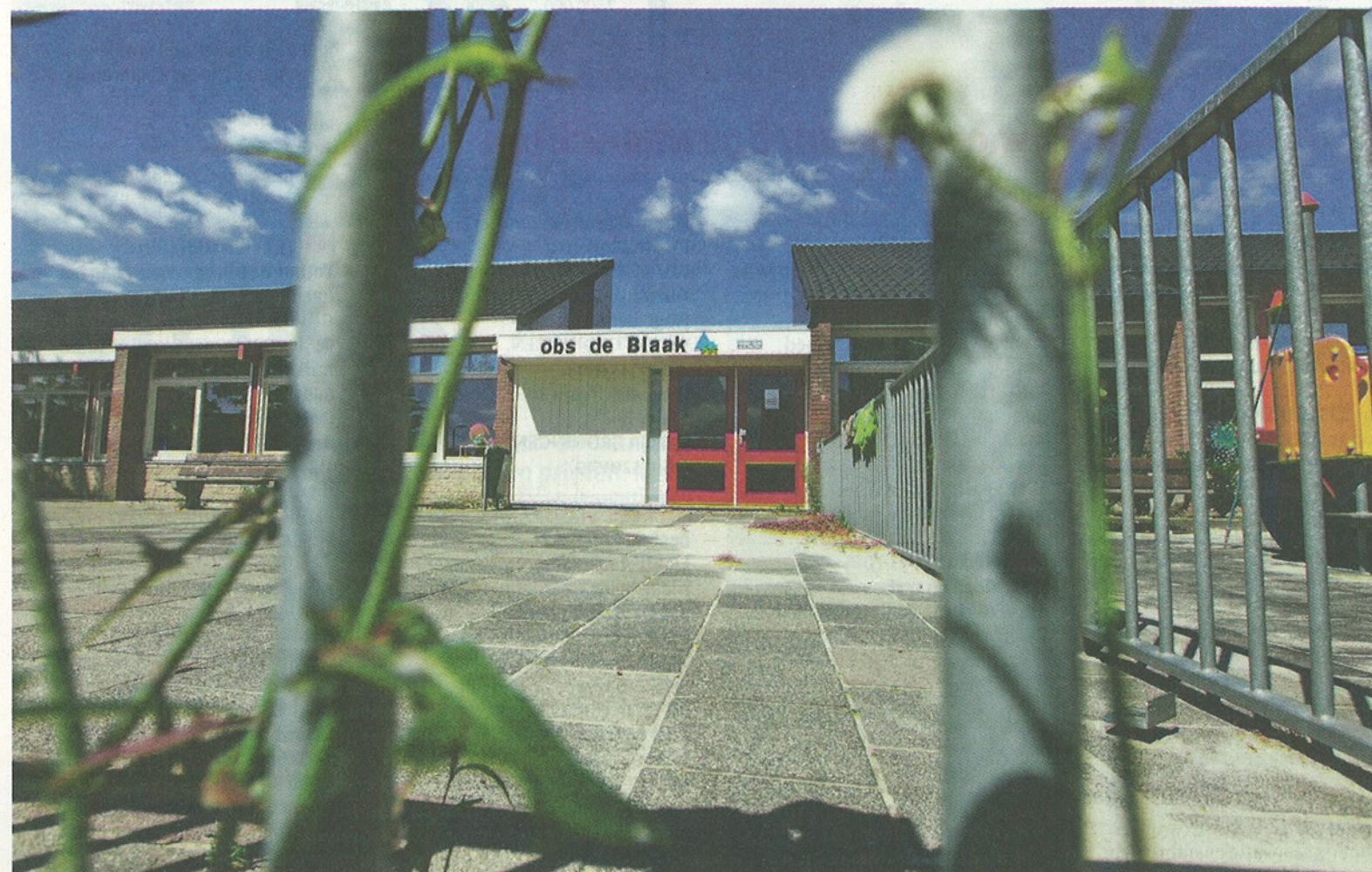
In augustus werd basisschool De Blaak in Tilburg gesloten nadat er asbest was aangetroffen. Foto: Novum/Ruud Verhalle
