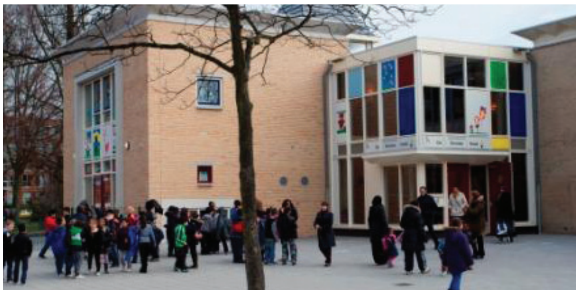
Project 11 Tijdelijke rijkssubsidie en cofinanciering door gemeente maakt realisatie van dertig Frisse Scholen van stichting De Haagse Scholen mogelijk
