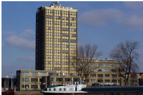
Figuur 1.6: GEB toren Rotterdam. Bron: BMA Amsterdam, 2011
