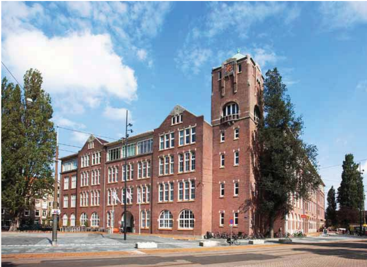
21 Het Timorplein is een voorbeeld van een plek waar een lokale voorziening met stedelijke uitstraling een upgrade kan betekenen voor de buurt. Het succes van de nieuwe functies in dit gebouw (jeugdherberg, concertlocatie, filmhuis, café en kantoren) komt mede voort uit de verbinding van het gebouw met de openbare ruimte. Foto: Edwin van Eis
