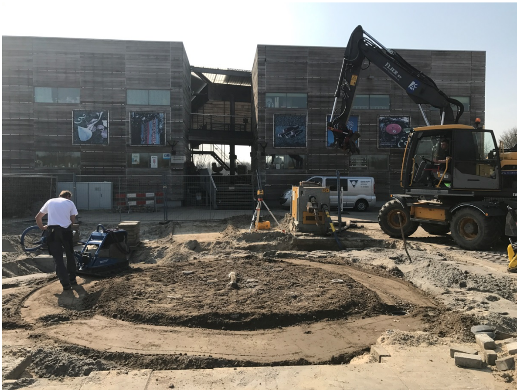
Fontein De Kemphaan in aanbouw
