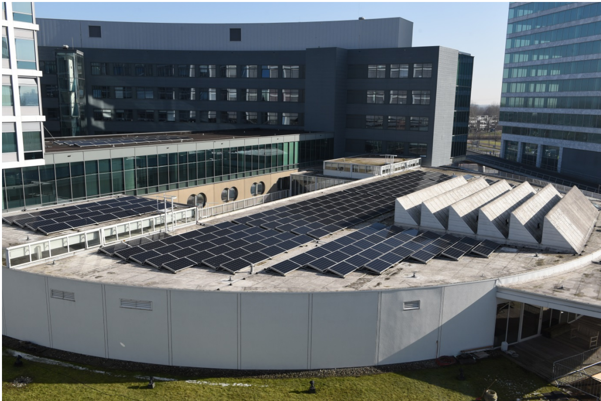
Aanbrengen van zonnepanelen op het stadhuis
