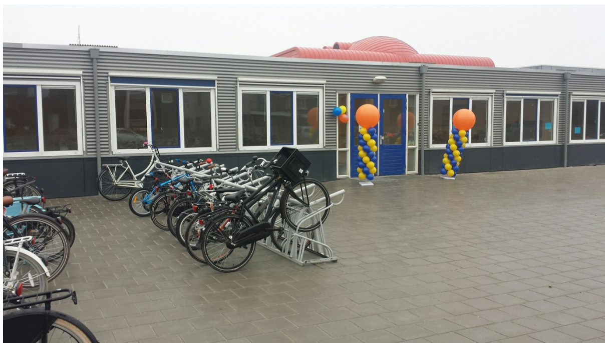
Tijdelijke onderwijs huisvesting Adriaen Blockstraat, Columbuskwartier
