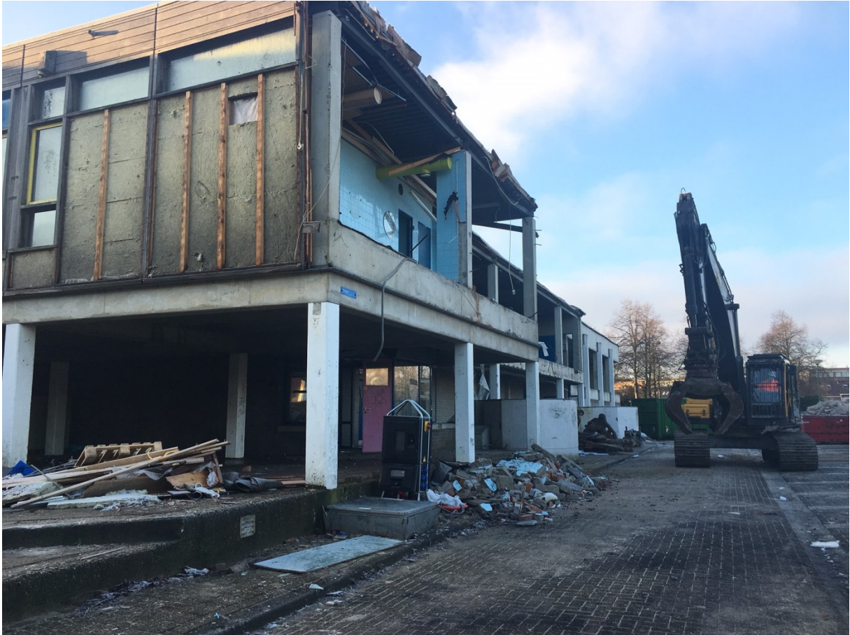
Sloop zwembad en sporthal Haven (materialen worden circulair hergebruikt)
