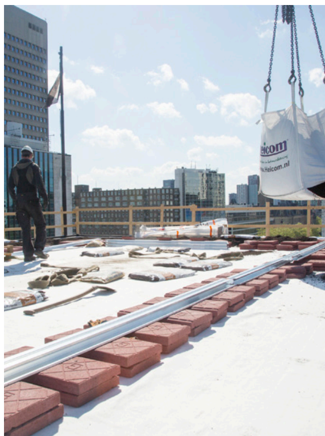
Slim!dak - aanleg [foto Tom Pilzecker]
