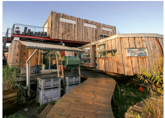
De Ceuvel - filterinstallatie [bron Metabolic]
