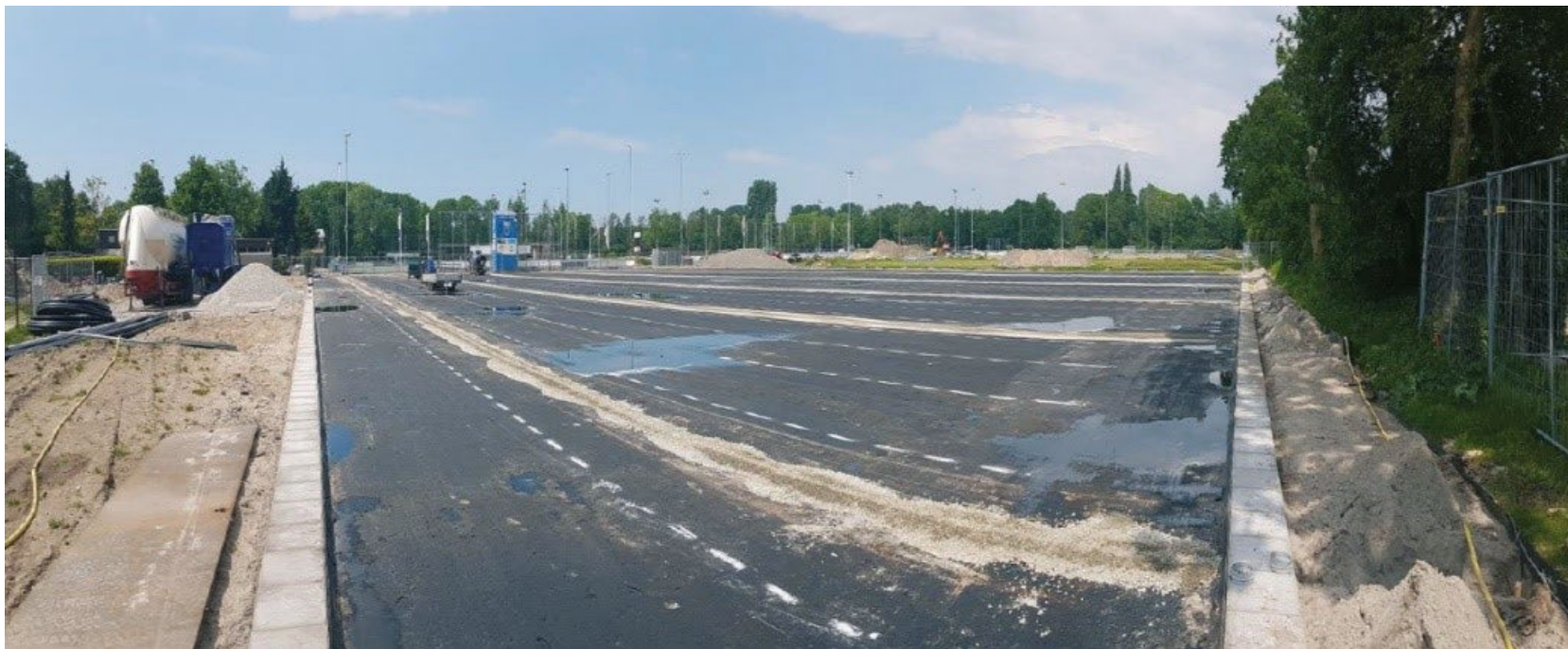
Aanleg topsport trainingscentrum hockey met waterberging en besproeiing van onderaf
